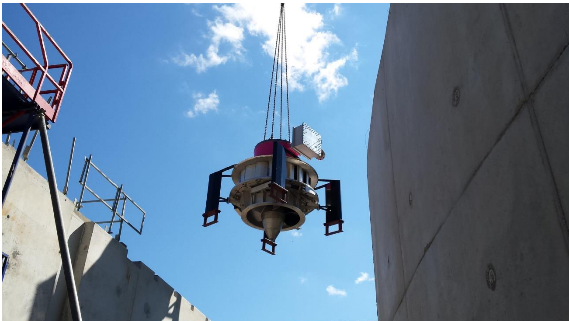
Einheben der DIVE-Turbine
