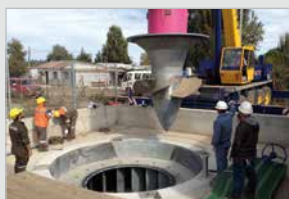
Montage på byggplats
