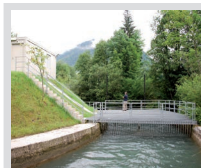
制御キャビネットの柔軟な配置 制御キャビネットの位置がタービンの位置から独立（例:耐洪水）
