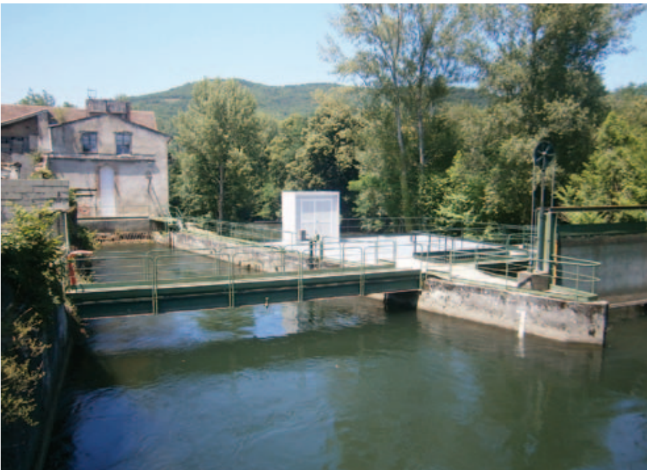
Abb. 4: Das Kraftwerk Crampagna, an dem die ersten Praxistests zur Feststellung der Fischmortalität an der Turbine durchgeführt wurden
