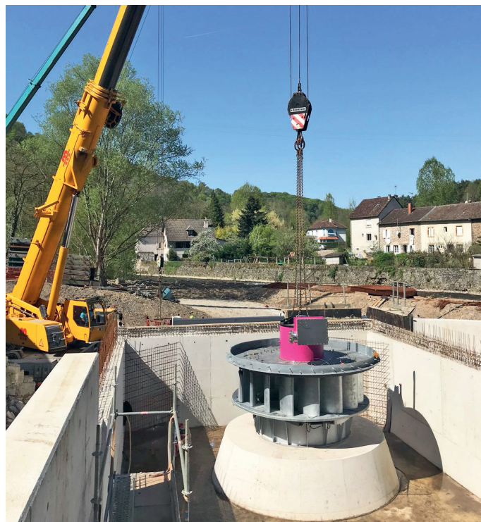
Die DIVE-Turbine mit trockenem, aktiv wassergekühltem Permanentmagnetgenerator reduziert den Bauaufwand auf ein Minimum – optimal für effiziente Niedriggefälle-Kraftwerke.
