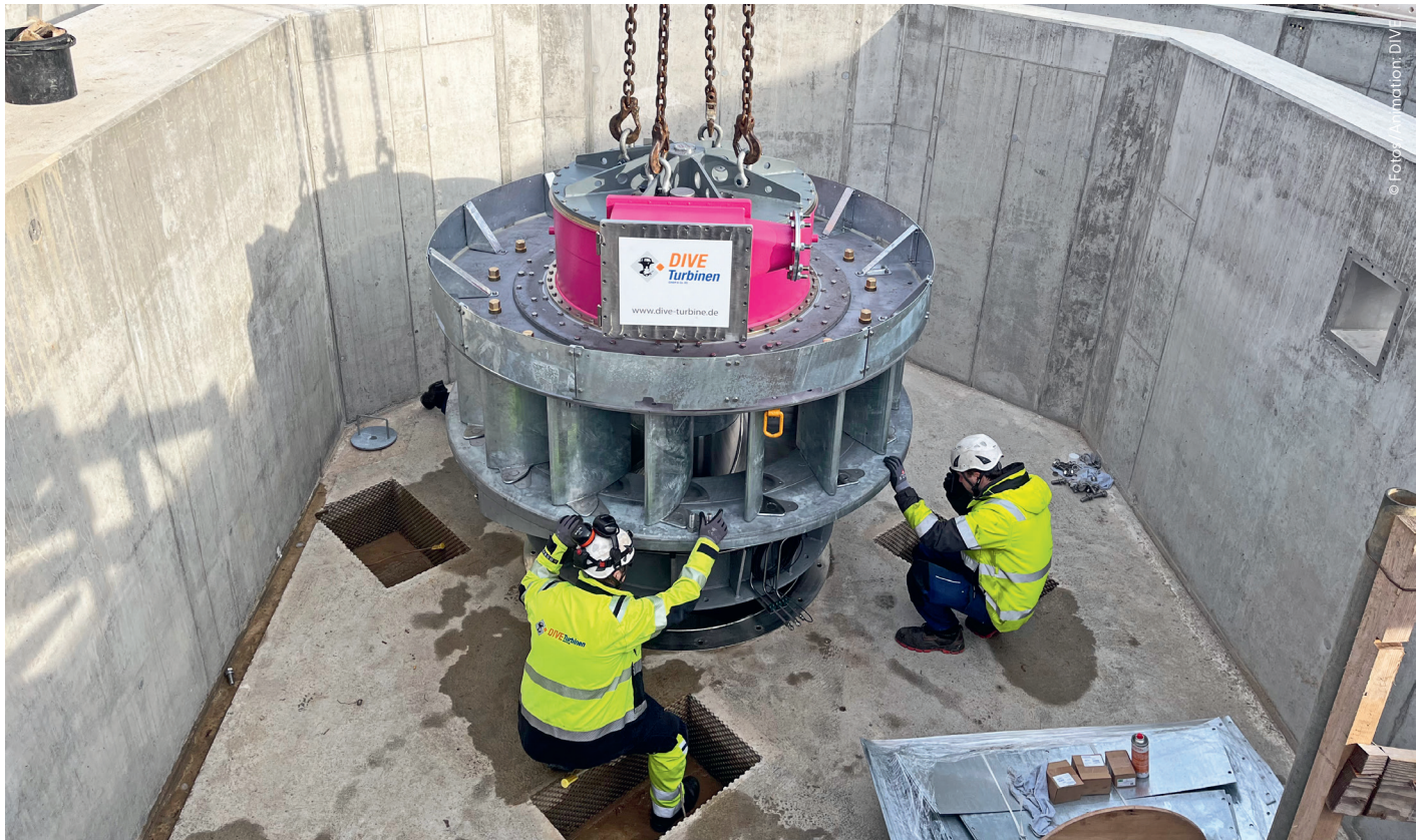
DIVE-Techniker bei der Installation der im Werk vormontierten und geprüften DIVE-Turbinen-Generatoreinheit. Unter diesen Voraussetzungen werden Montagezeiten der fischfreundlichen Turbinen auf ein Minimum reduziert.
