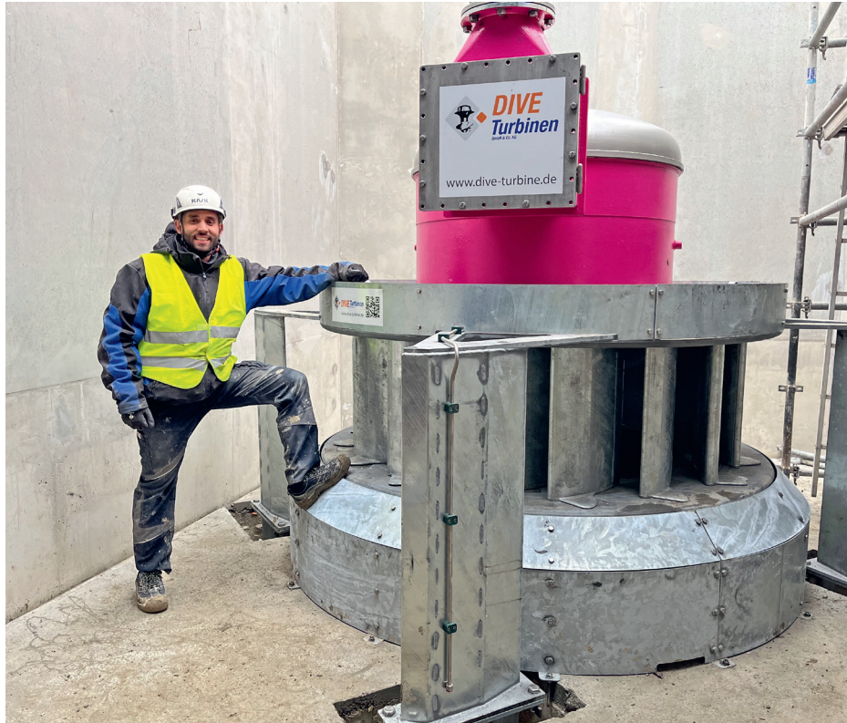
Typischer DIVE-Turbinenaufbau in einer vereinfachten Wasserkammer.
