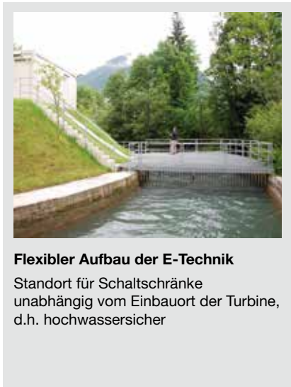
Kein Krafthaus notwendig Geringer Platzbedarf für Nebenaggregate wie Hydraulik und Schaltschränke
