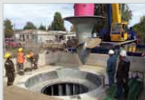
Montage vor Ort
