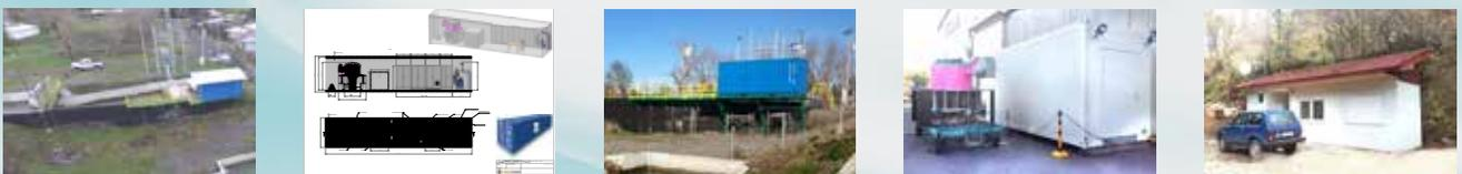
El equipo electrónico y el equipo auxiliar de la DIVE-Turbine se instalan en un contenedor de transporte. El contenedor se utiliza para el transporte y permanece en el sitio como una casa de máquinas. Está equipado con un sistema de enfriamiento de circuito cerrado y, por lo tanto, es independiente de las condiciones climáticas del sitio.
